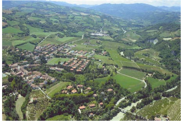
La stazione di Fontanelice a valle del ponte
