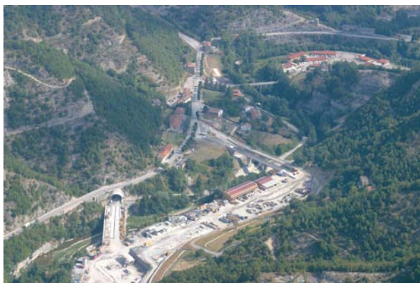
Il cantiere per l'alta velocità a San Pellegrino
